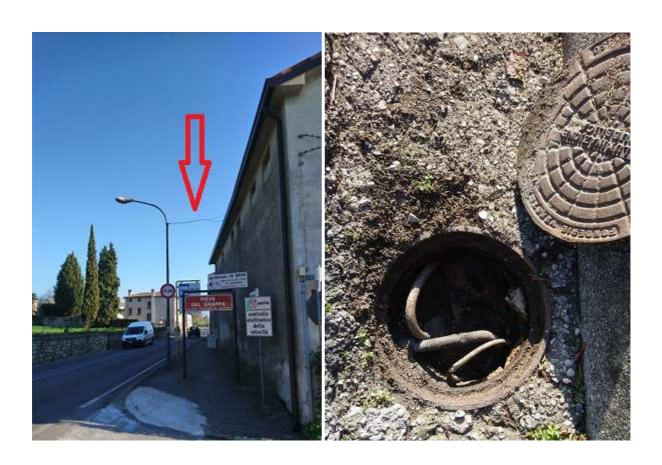
In altre parole le linee in questione necessitano di un intervento tanto urgente quanto prioritario di ammodernamento e messa in sicurezza che include opere edili (scavo, posa dei cavidotti, rifacimento del marciapiedi, ecc.), spostamento dei plinti di fondazione, nuovi pali e nuove armature.
